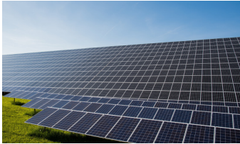
| 厦门自贸片区港务电力光伏项目
