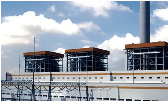
| 中国电建集团光伏电缆项目(山东)
