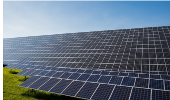
| 厦门自贸片区港务电力光伏项目
